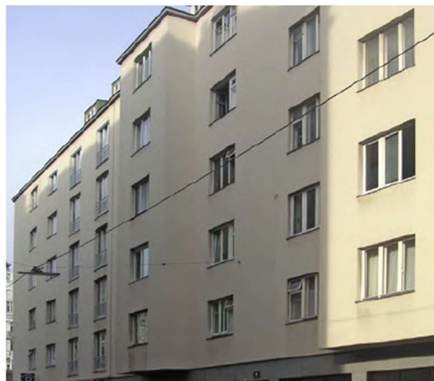
Abb. 13: Doppelfenster ohne Sprossenteilung – 1040, Faulmannsgasse 6 (Quelle: Wiener Fenster. In: Stadtentwicklung und Stadtplanung. Hrsg.: MA 18. Wien 2014)
