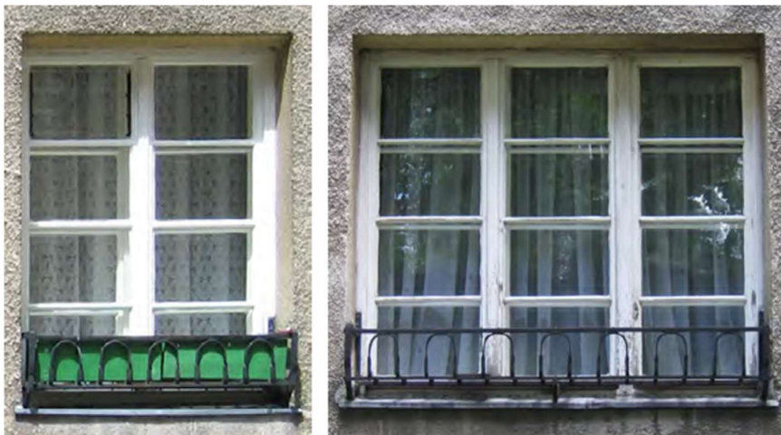
Abb. 12: Normtypus zwei- und dreiflügelig – 1150 Wurzbachgasse 2-8 (Quelle: Wiener Fenster. In: Stadtentwicklung und Stadtplanung. Hrsg.: MA 18. Wien 2014)
