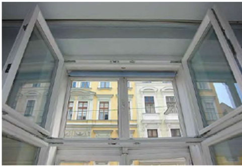
Abb. 35: Ansicht der Innenflügel nach der Sanierung (Quelle: Wiener Fenster. In: Stadtentwicklung und Stadtplanung. Hrsg.: MA 18. Wien 2014)
