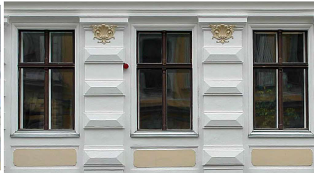
Abb. 36: Ansicht der Außenflügel nach der Sanierung (Quelle: Wiener Fenster. In: Stadtentwicklung und Stadtplanung. Hrsg.: MA 18. Wien 2014)
