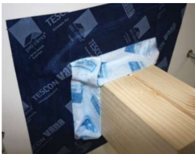
Abb. 22: Anschluss mittels Putzanschlussband
