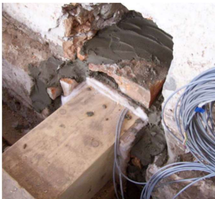
Abb. 53: Überblattung mit Aerogelmatte und Dämmung
