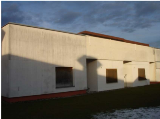
Abb. 33: Ansicht des Versuchsgebäudes
