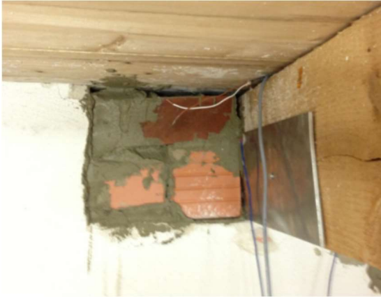
Abb. 35: Balkenanschluss mit Aluminiumblech
