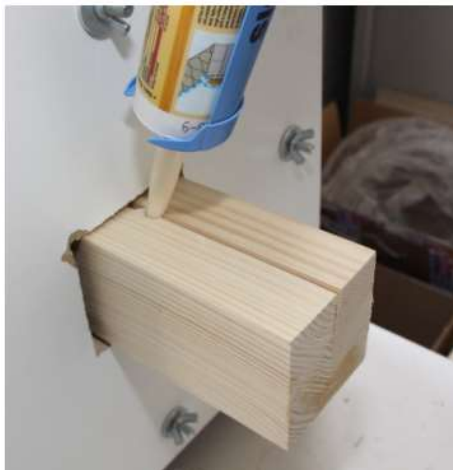
Abb. 31: Ausfüllen mit Injektionsmasse
