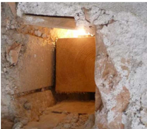
Abb. 51: Überblattung mit Aerogelmatte
