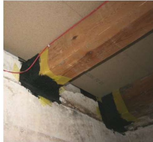
Abb. 26: Praxiseispiel der Dickbeschichtung
