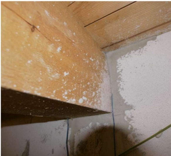
Abb. 40: Abgedichteter Balkenanschluss
