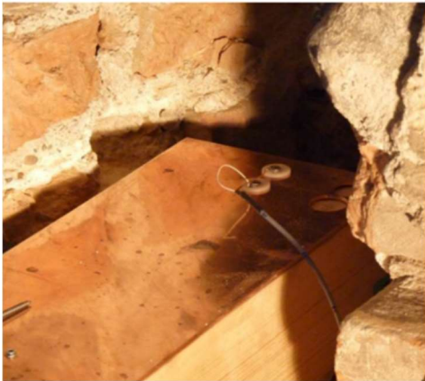
Abb. 54: Überblattung mit Mörtelbett und Kupferplatte
