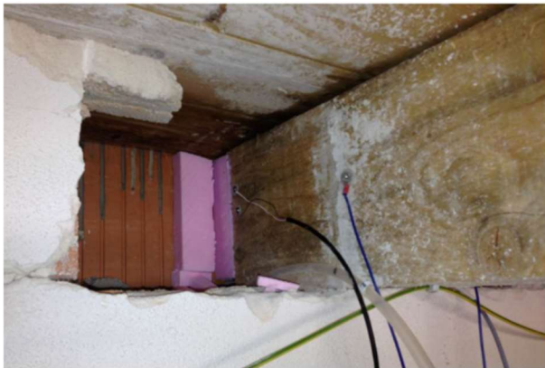
Abb. 37: Balkenanschluss mit Dämmung und erzwungener Konvektion
