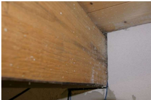
Abb. 38: Balkenanschluss mit Fuge
