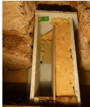
Abb. 49: Gipskartonbox um Schlitzblech
