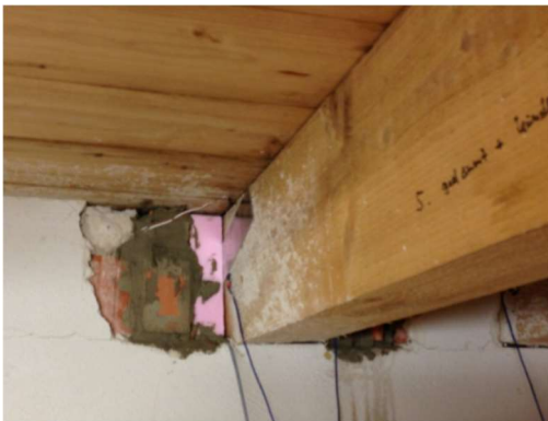
Abb. 36: Balkenanschluss mit Dämmung und Fuge
