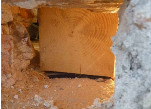
Abb. 52: Überblattung mit Elastomerauflager
