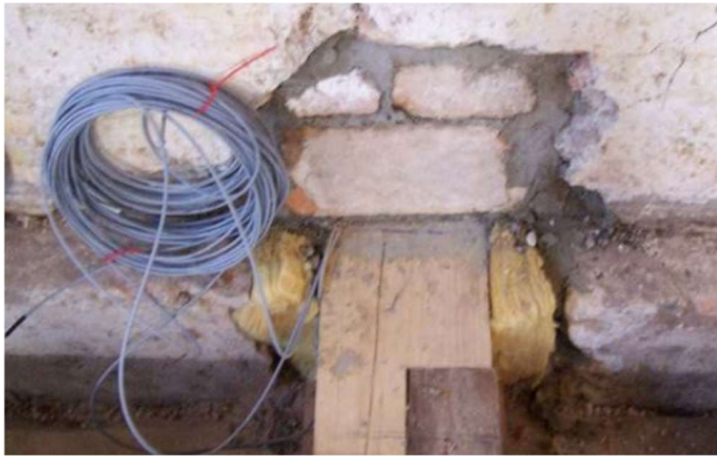
Abb. 48: Überblattung mit Mörtelbett und Dämmung
