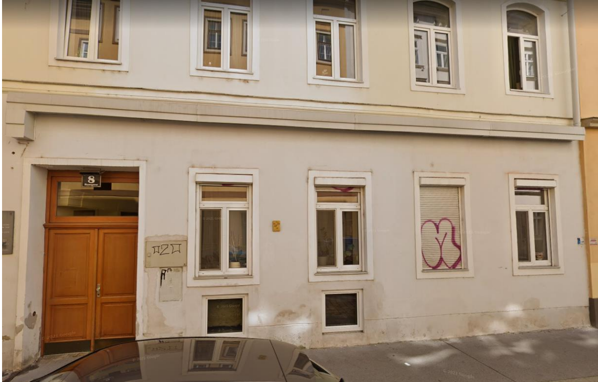
Abbildung 31 Straßenseitige Fassade Dianagasse
