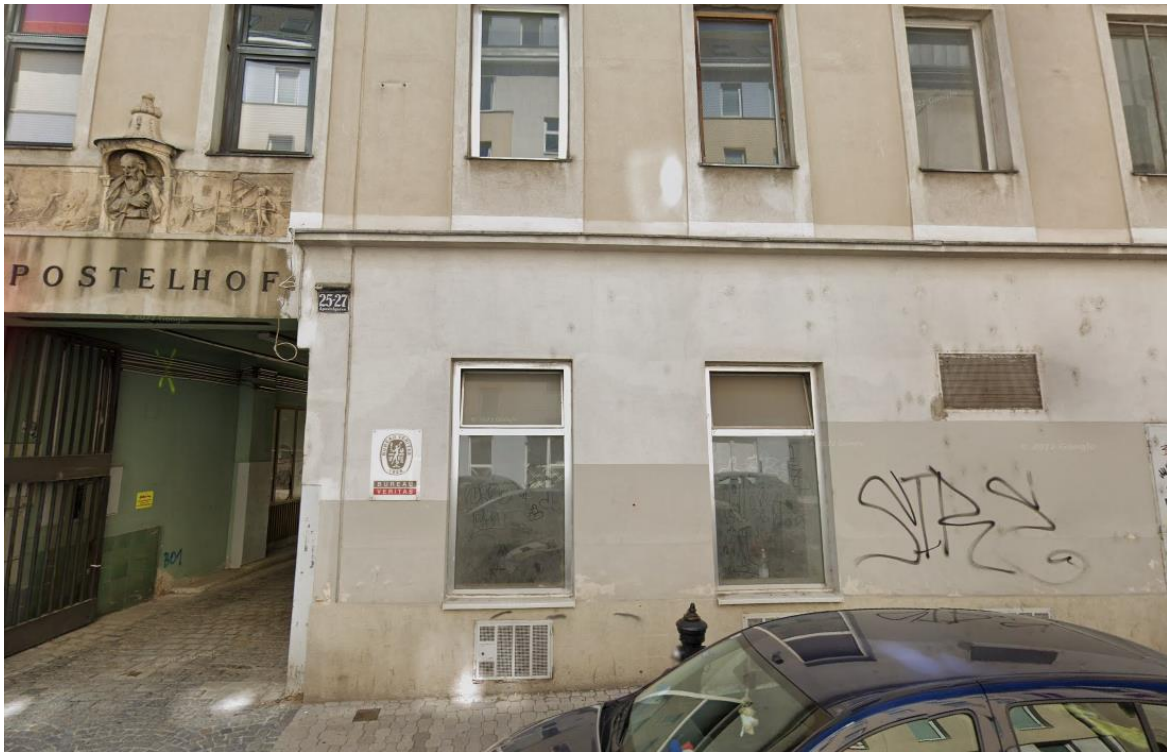
Abbildung 35 Straßenseitige Fassade Apostelgasse
