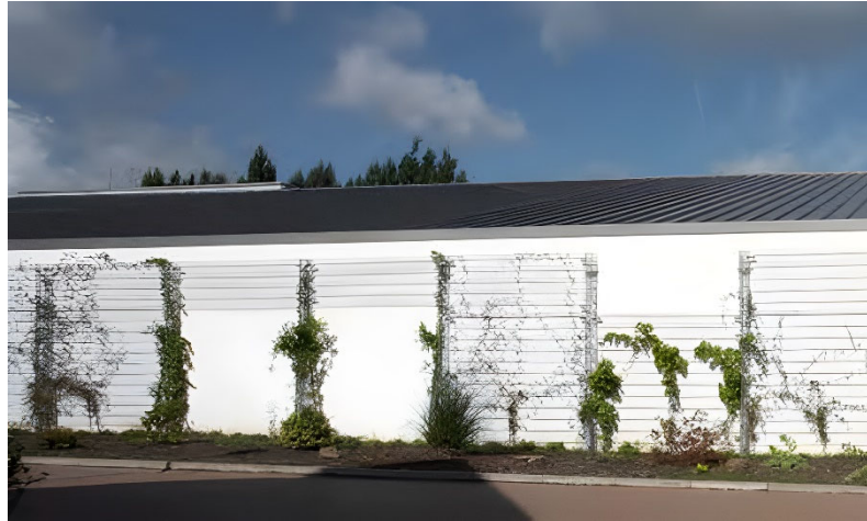
Abb. 4: Bodengebundene Begrünung mit Gerüstkletterpflanzen
