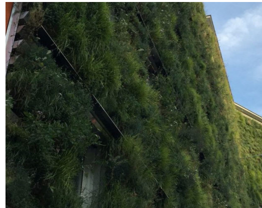
Abb. 35: Tröge zur Begrünung des MA48 Gebäudes
